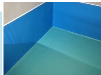
Depósitos de retención de obra con liner reforzado
